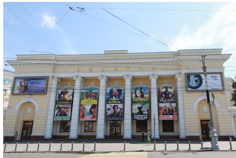
Здание кинотеатра «Спартак» — знаковое здание для центральной части Воронежа. Хотя афиши фильмов кинотеатру необходимы, им нужно придумать место и вид, менее разрушительный для облика здания. Можно, например, сделать их однотонными.
