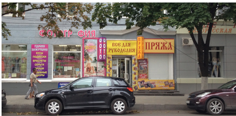
Увешанные рекламой входные группы нарушают общий облик дома. Подобные рекламные конструкции сейчас не регламентируются. Ул. Пушкинская, 4.
