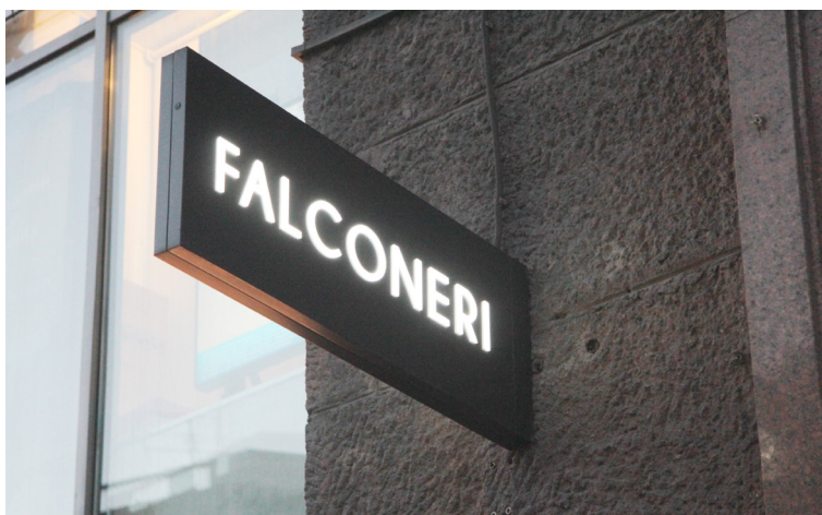
Кронштейн с подсветкой, установленный вплотную к фасаду здания. Москва, ул Тверская.
