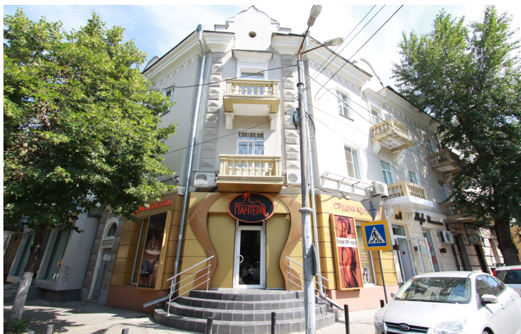
Архитектурный облик аккуратного особняка XIX века испорчен рекламой солярия. Подобная отделка недопустима для исторических зданий. (п.1.1) Ул. Дзержинского, 3
