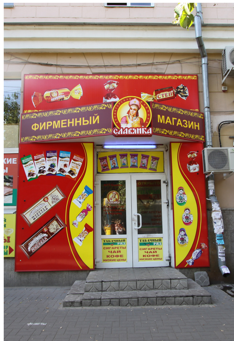
Избыточная реклама магазина. Вывеской считать ее нельзя, так как на вывеске могут располагаться только название компании, логотип и тип деятельности. Размещение изображений продуктов недопустимо. (п. 3.2.1 — здесь и далее красным отмечаются ссылки на пункты правил части 3). Площадь Ленина, 8.
