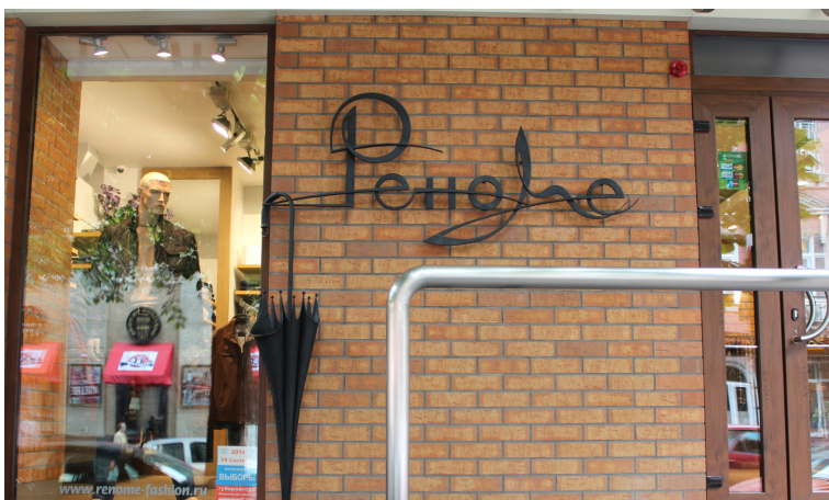
Табличка из отдельных букв, расположенная непосредственно на фасаде здания. Табличка непропорционально большая и должна быть заменена. Воронеж, Комиссаржевской,5.
